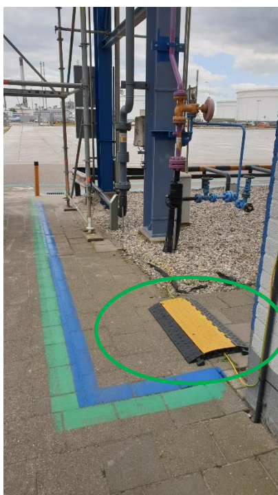
Juiste Montage methode aardkabel
