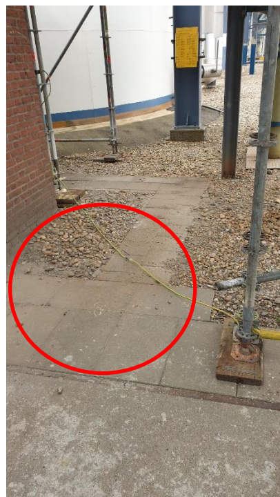
Onjuiste montage methode aardkabel
