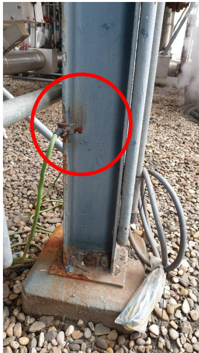
Onjuiste montage methode aardkabel
