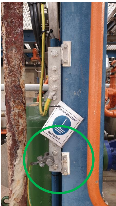
Juiste Montage methode aardkabel
